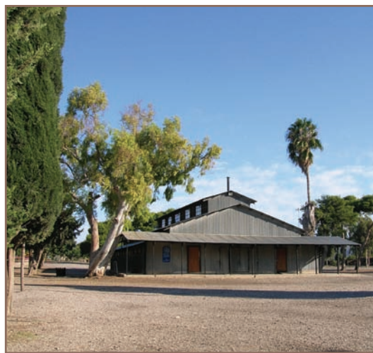
איור 36: מבנה המקלחות והחיטוי לאחר שחזור
